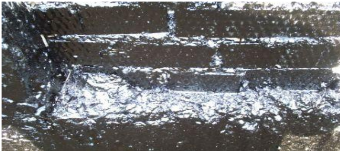
изображение 1 ( гидроизоляция сложных архитектурных форм и различных поверхностей бетон - кирпич)
