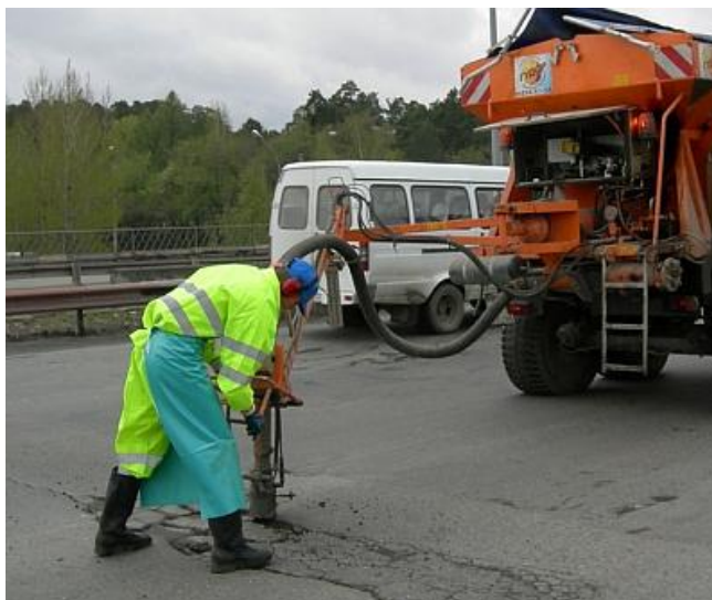
изображение 13, 14 (использование мастики МБРД-90, обработка швов и стыков)
