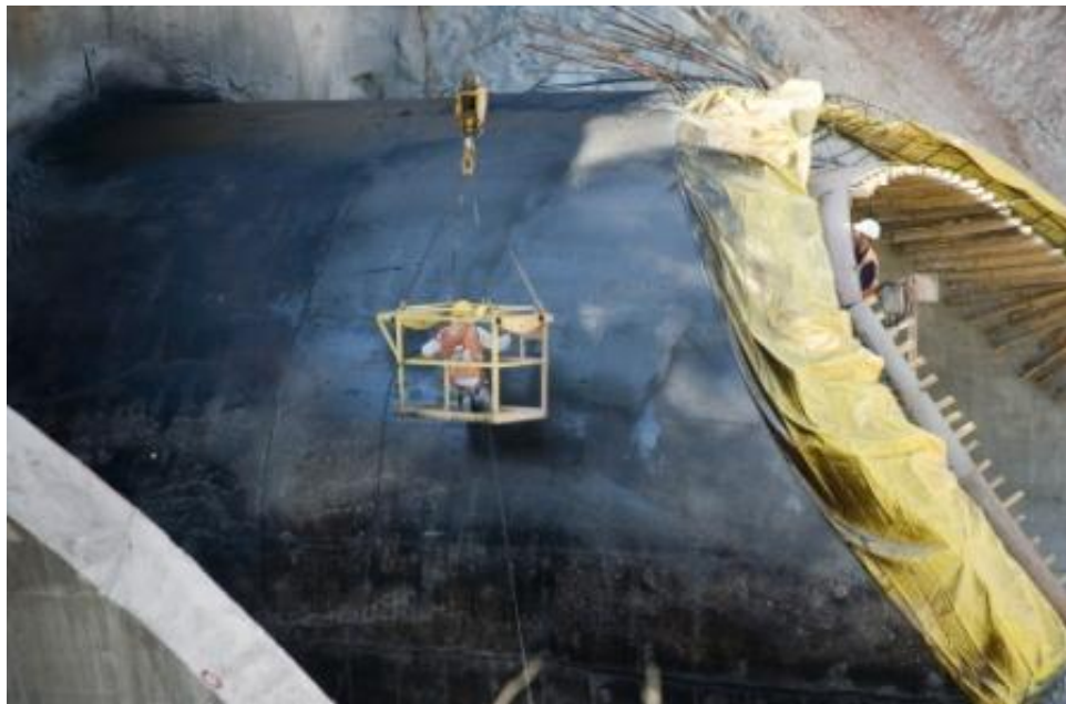
изображение 19 (внешняя гидроизоляция стенок тоннеля)
