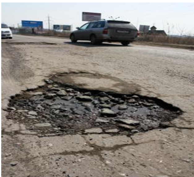
изображение 11, 12 (использование мастики МБРД-90, ямочный ремонт)
